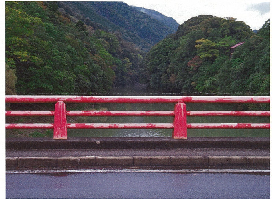
-塗装前- 東（上流）側
